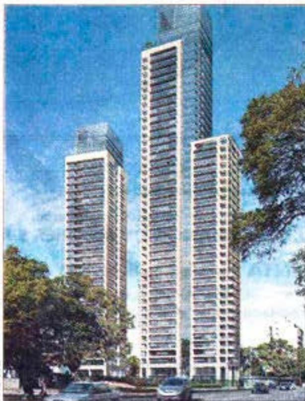
Alta gama en residencias en altura
